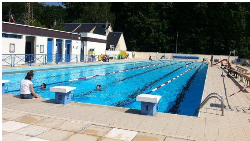
Piscine intercommunale d'Épernon
