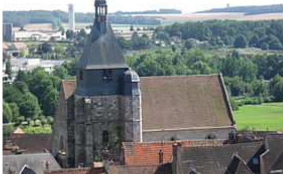
Eglise Saint-Pierre (XVIe siècle) EPERNON
